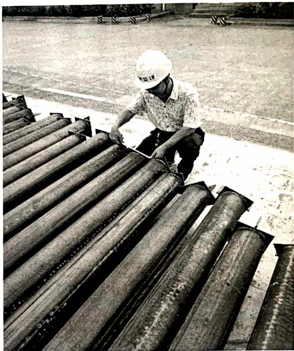
进场加固材料检查
