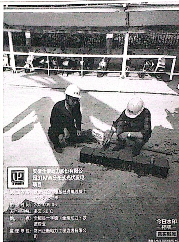
欧波厂区车棚基础浇筑混凝土见证取样
