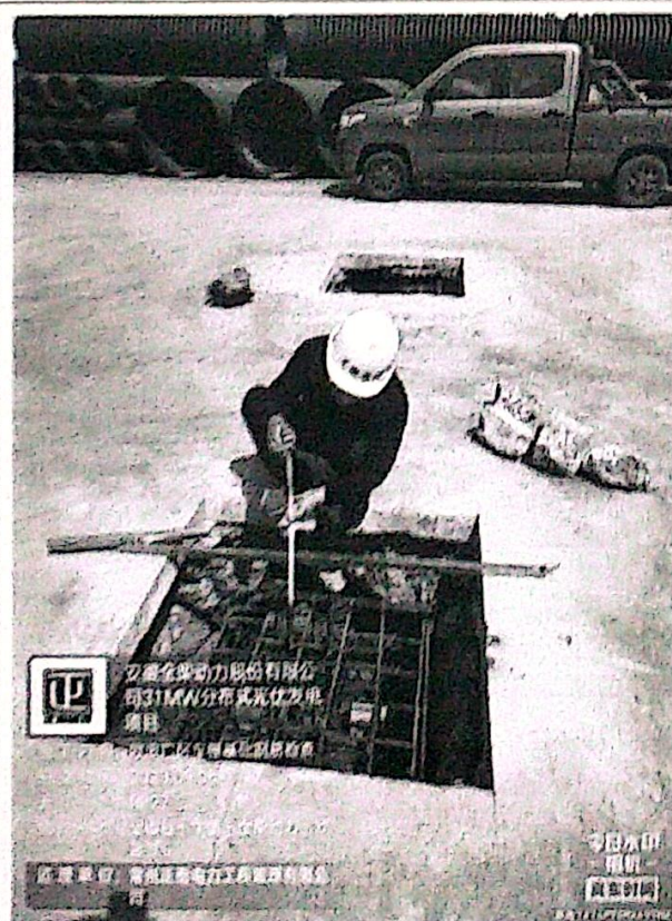
欧波厂区车棚基础钢筋检查
