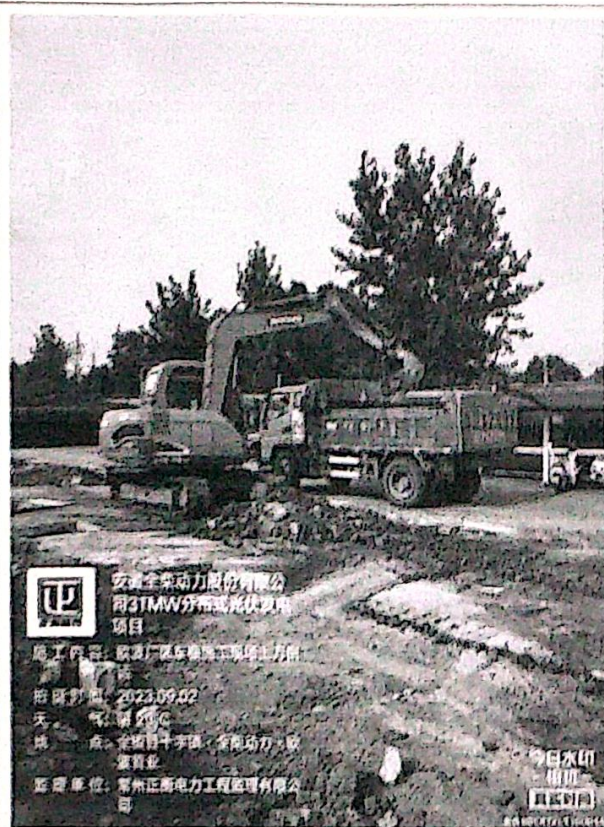
欧波厂区车棚施工现场土方倒运
