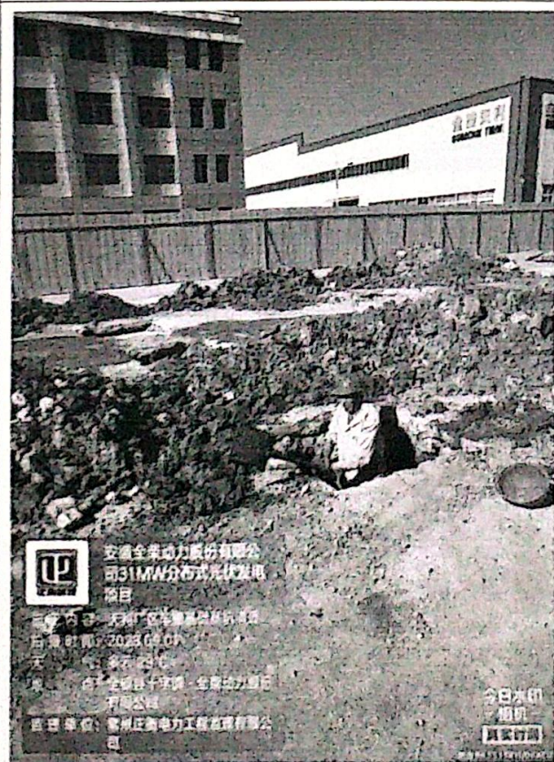
天利厂区车棚基础基坑清理
