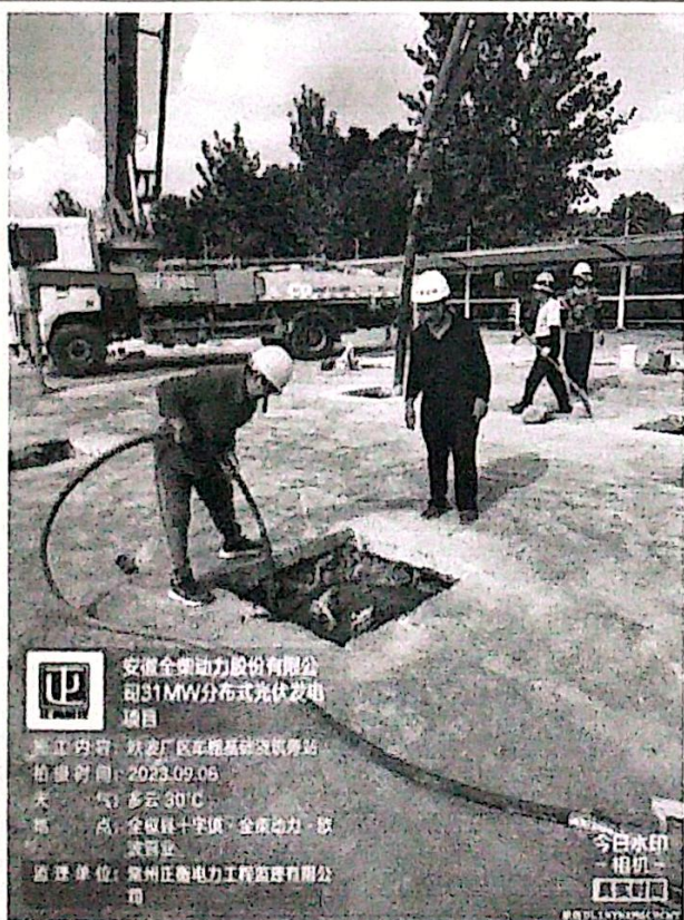
欧波厂区车棚基础浇筑旁站
