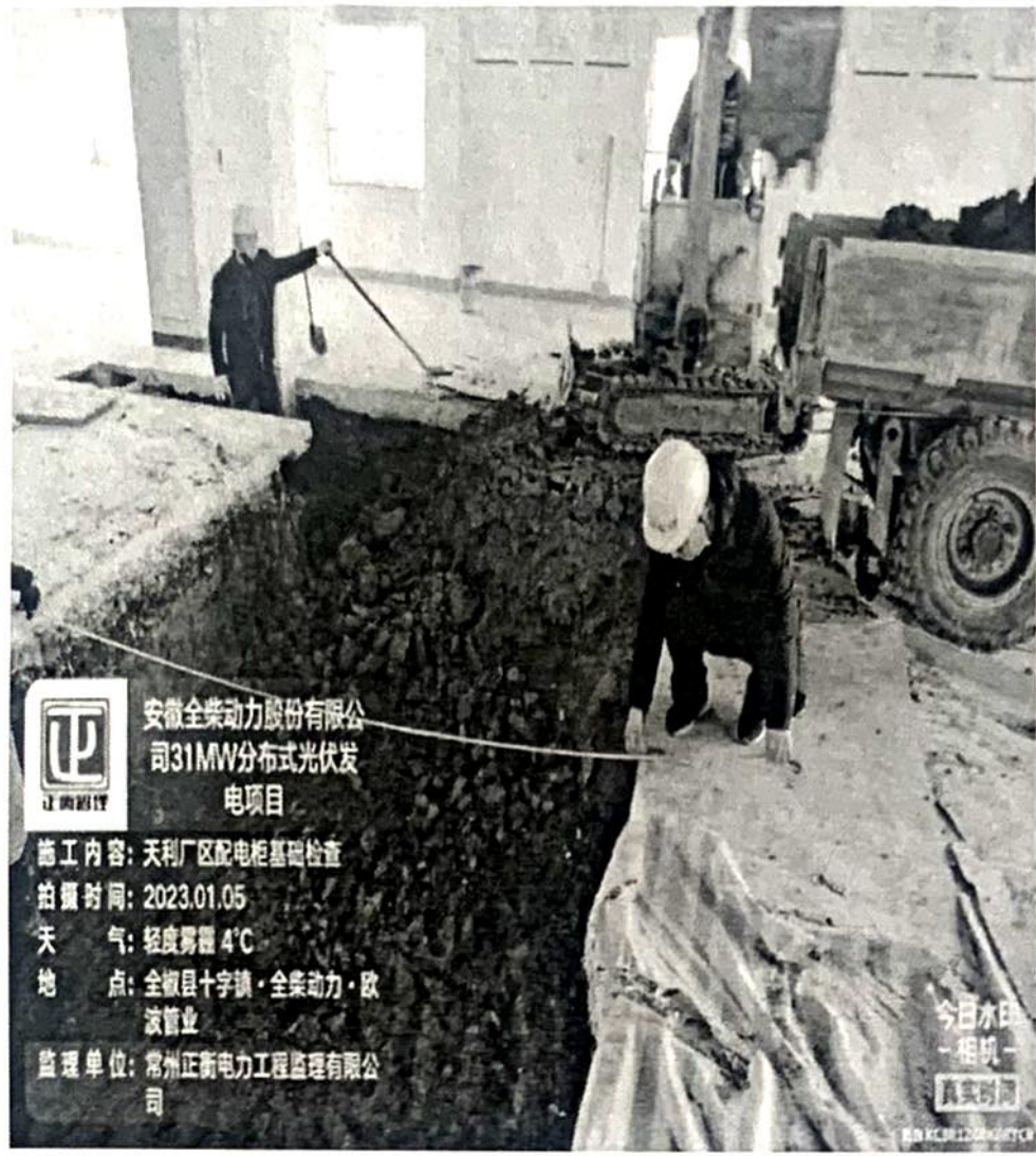
天利厂区配电柜基础检查
