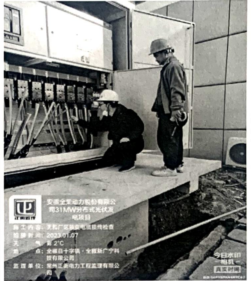
天和厂区箱变电缆接线检查
