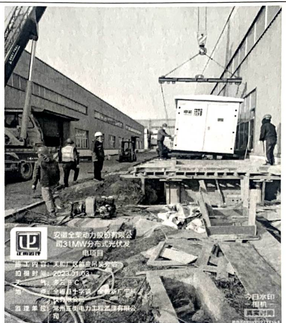
天和厂区箱变吊装旁站
