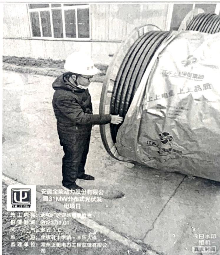
天和厂区进场电缆材料检查
