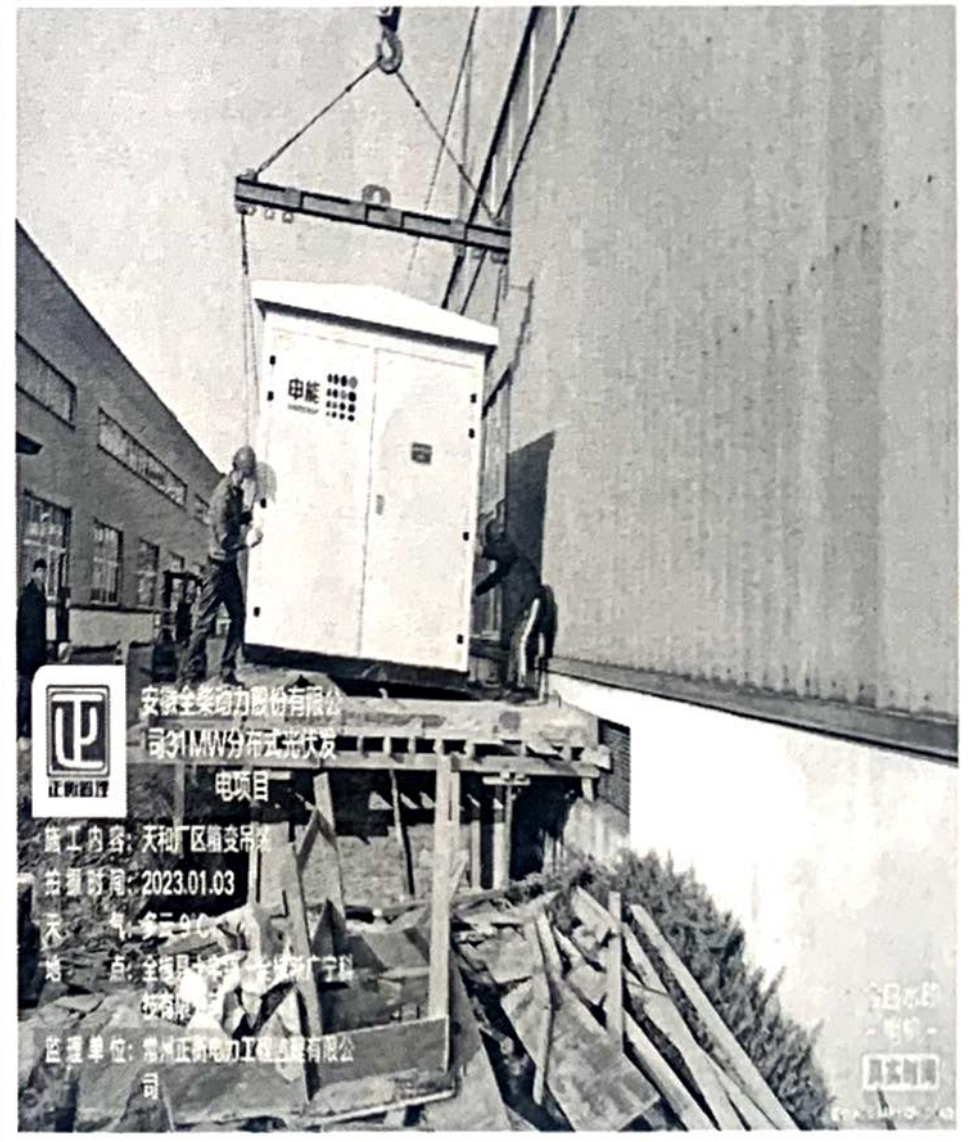
天和厂区箱变设备吊装
