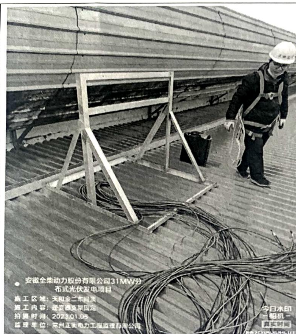
天和厂区逆变器支架安装检查
