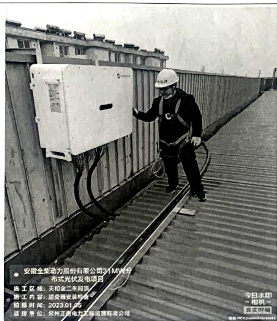
天和厂区逆变器安装检查
