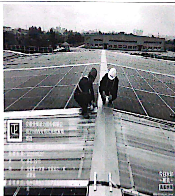
欧波厂区透明瓦安装巡视检查
