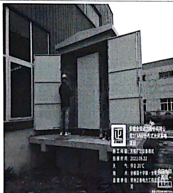
天和厂区设备调试
