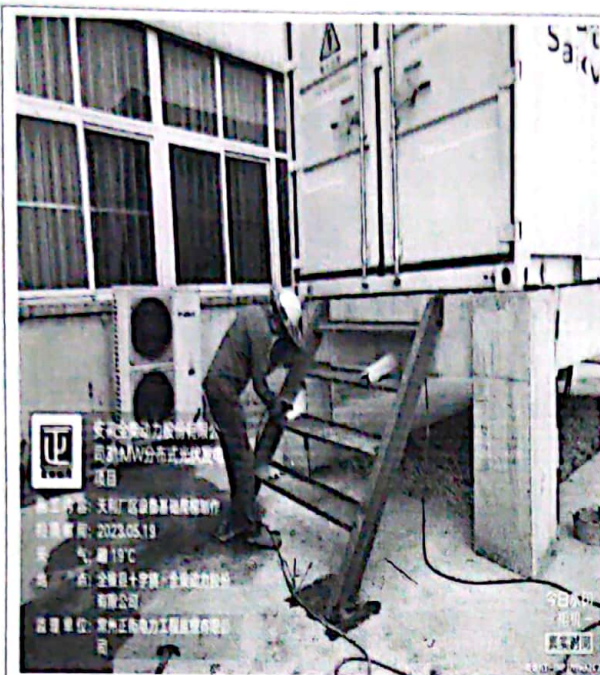
天和厂区设备基础爬梯制作
