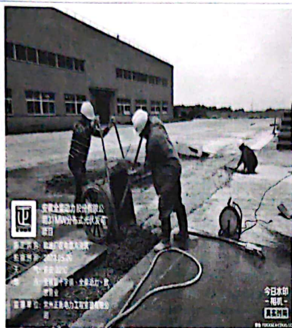
欧波厂区电缆沟浇筑
