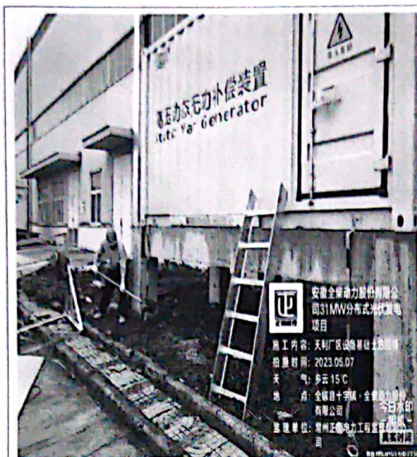
天利厂区设备基础土方回填
