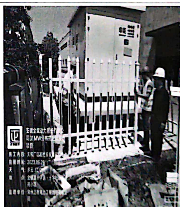
天和厂区围栏安装巡视检查
