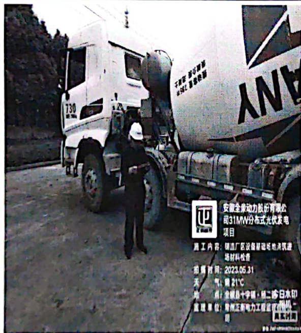
铸造厂区设备基础场地浇筑进场材料检查
