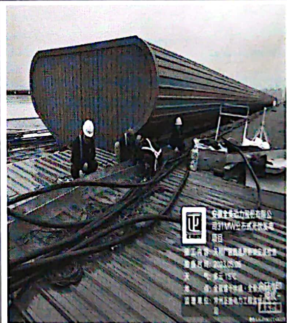
天利厂区桥架安装检查
