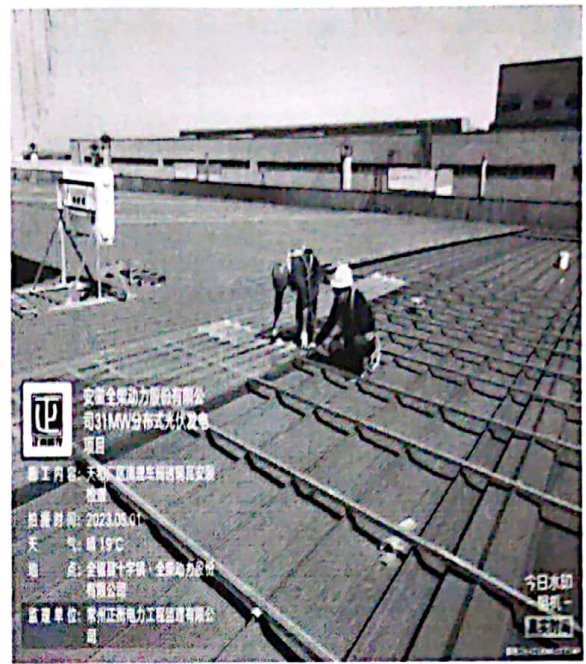
天和厂区透明瓦安装检查
