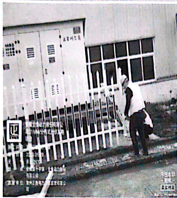
天利厂区围栏安装
