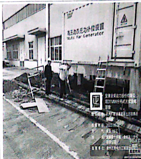
天利厂区设备基础土方回填巡视检查
