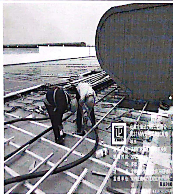
天利厂区彩钢瓦安装
