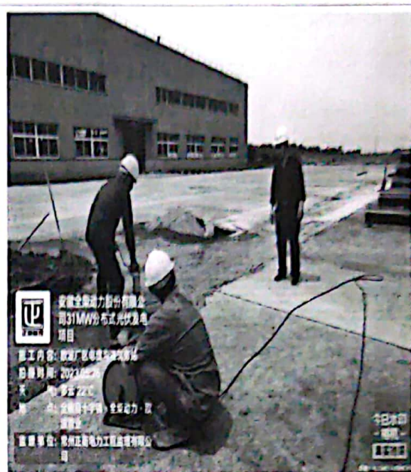
欧波厂区电缆沟浇筑旁站
