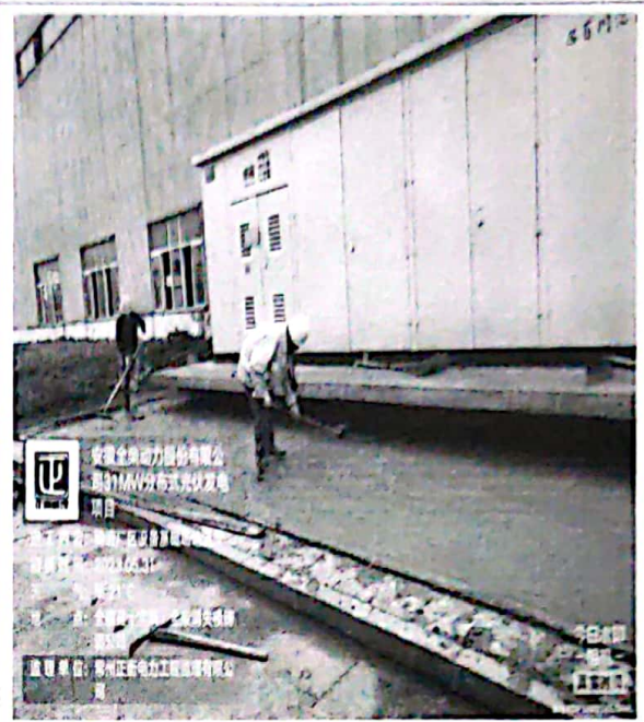
铸造厂区设备基础场地浇筑
