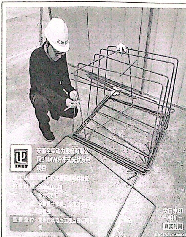
欧波厂区光伏车棚进场材料检查
