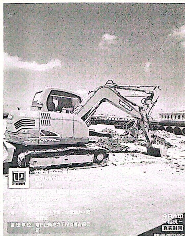
欧波厂区光伏车棚基础开挖施工
