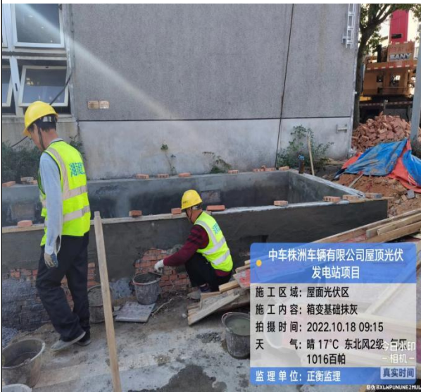
箱变基础抹灰
