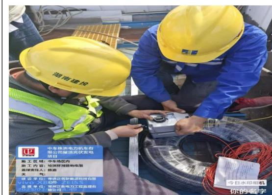
检测电缆绝缘
