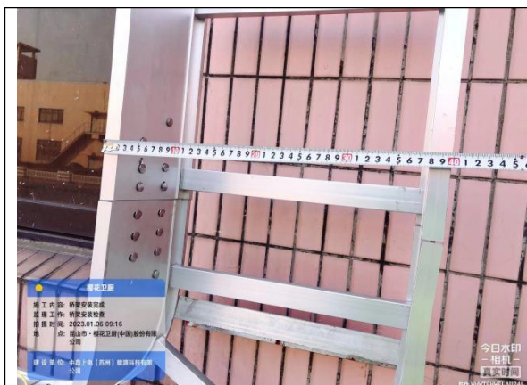
下墙桥架安装
