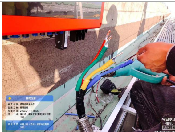
过路部分电缆穿管敷设—监理旁站
