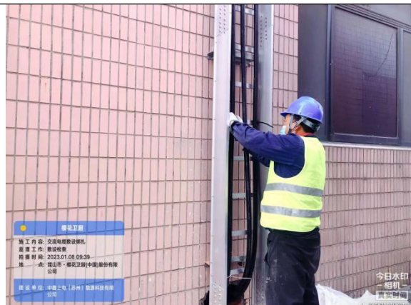
垂直桥架安装完成—监理检查
