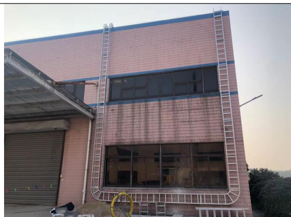
组件安装情况
