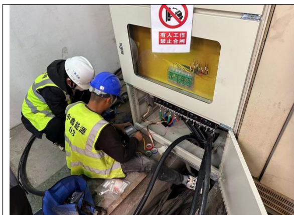
组串电压插接线—监理检查
