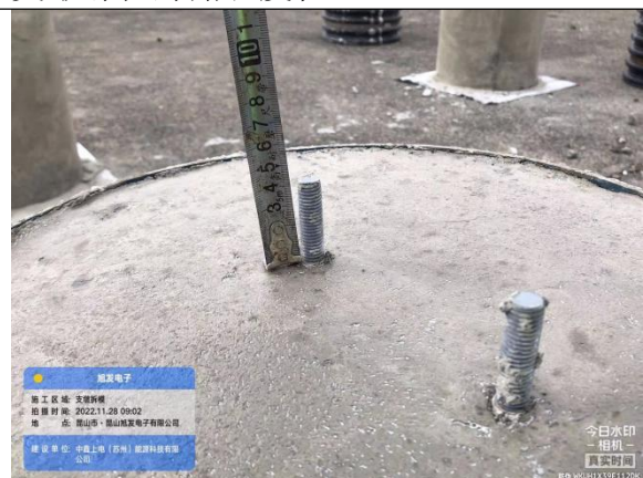
支墩螺栓外露长度检查
