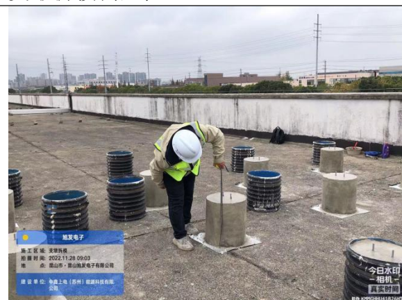
支墩拆模测量检查
