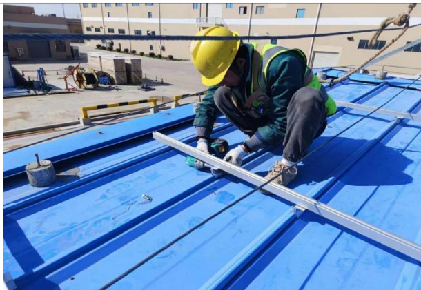
车棚导轨安装
