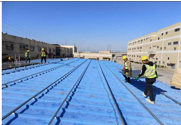
车棚直流电缆敷设
