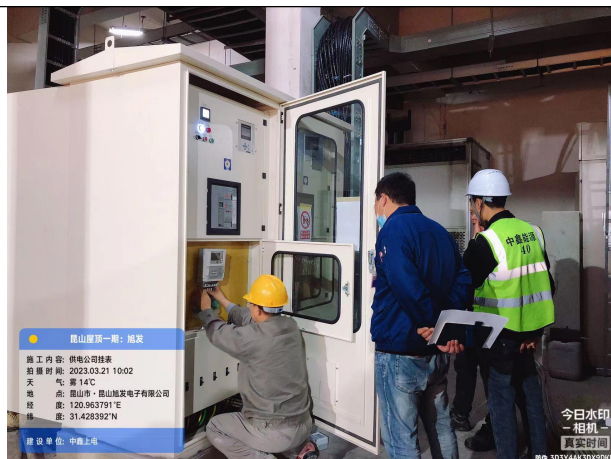
安全文明施工
