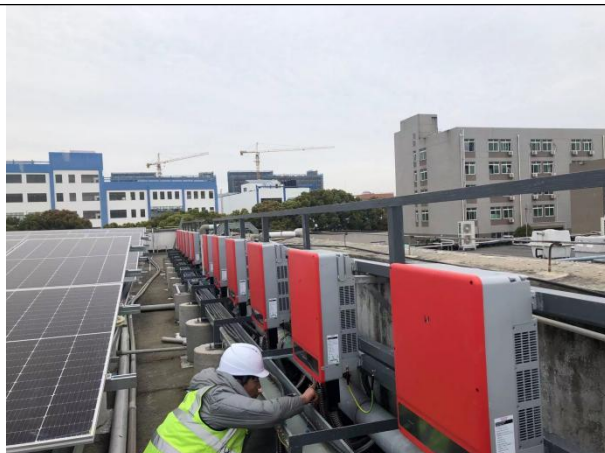
支架安装水平度监理检查
