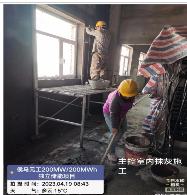
主控楼室内抹灰施工
