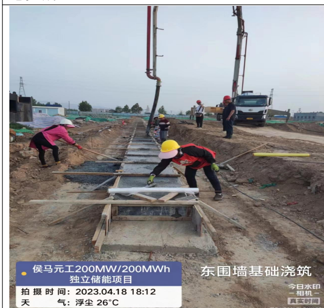
东围墙基础浇筑
