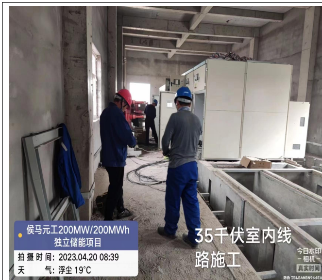
35KV 室内线路施工
