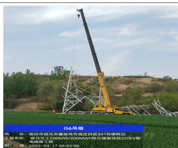
G6 吊装组塔
