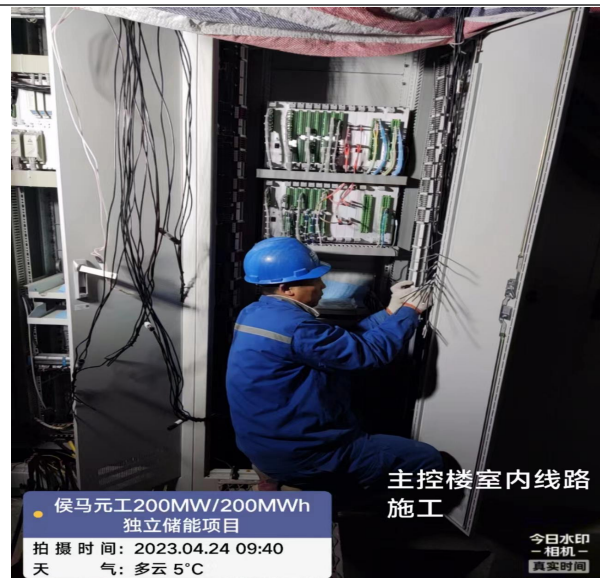
主控楼室内线路施工
