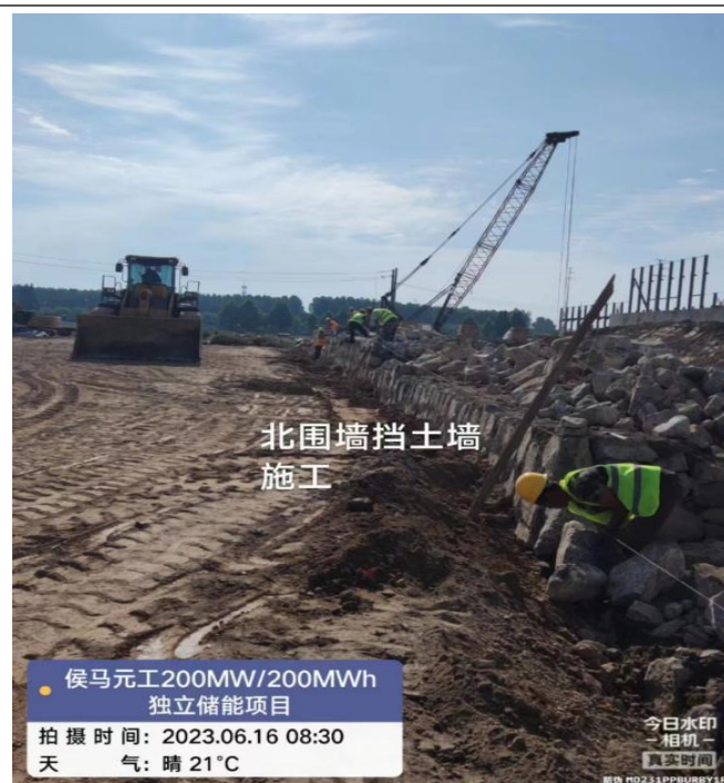
北围墙挡土墙施工
