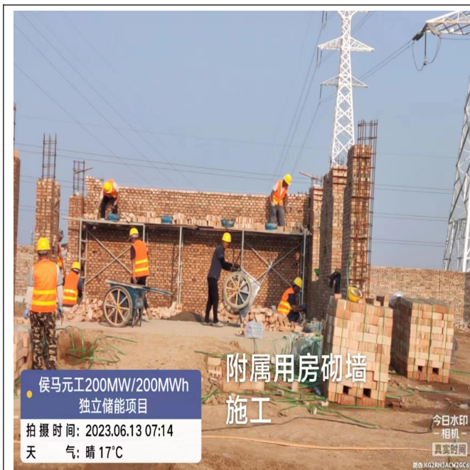
附属用房砌墙施工
