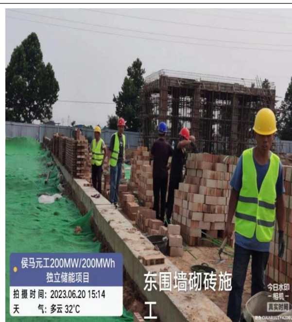
东围墙砌筑施工
