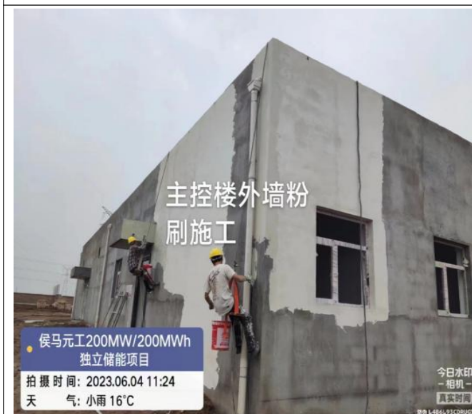
主控室外墙粉刷施工
