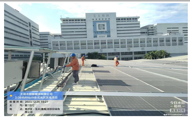
光伏直流电缆敷设
