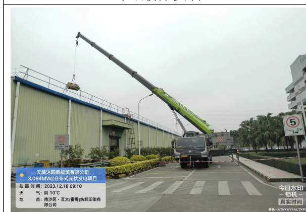
材料设备吊装
