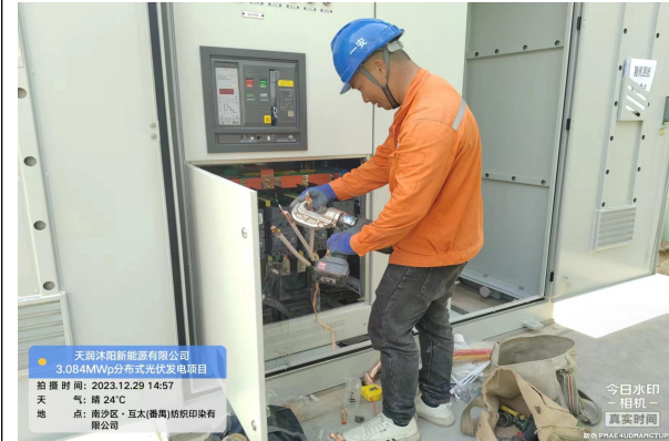
箱变低压室交流电缆终端制作
