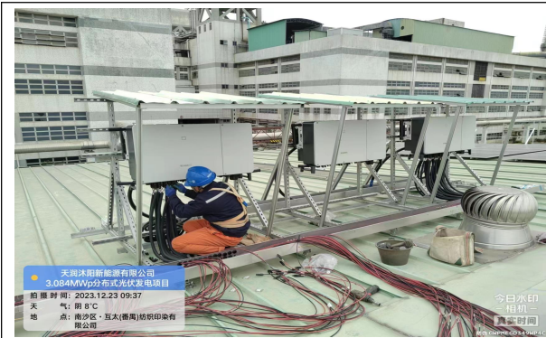
光伏逆变器直流侧接线
