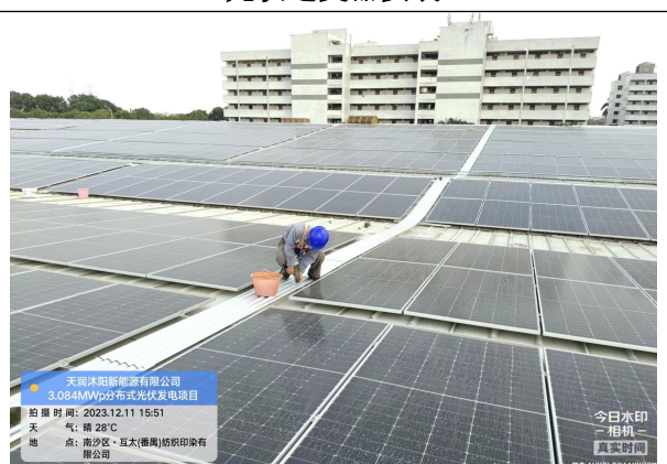
检修通道安装
