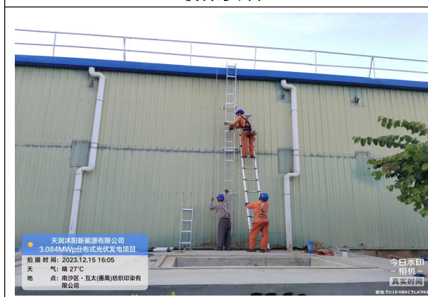
下墙桥架安装
