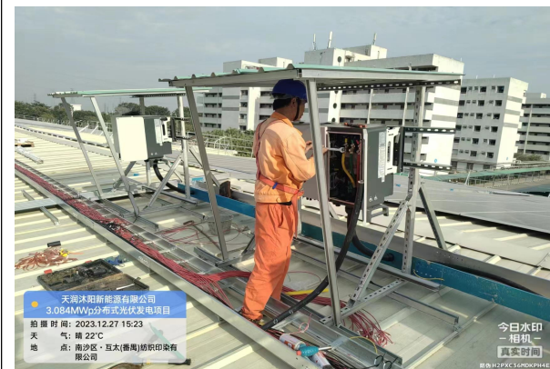
光伏逆变器交流侧接线
