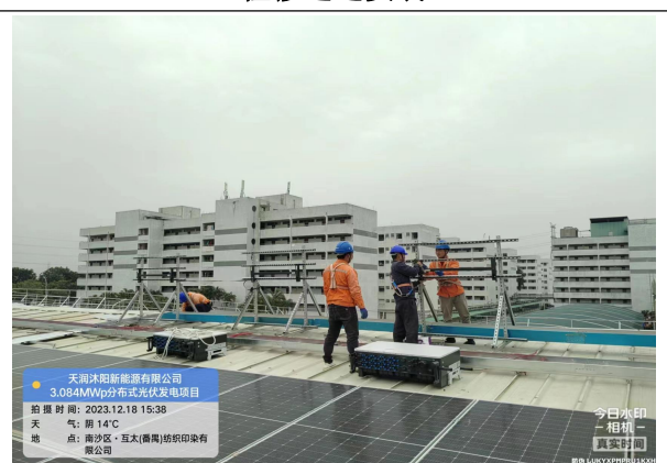
光伏逆变器支架安装
