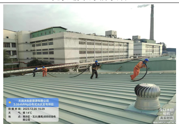
低压交流电缆敷设
