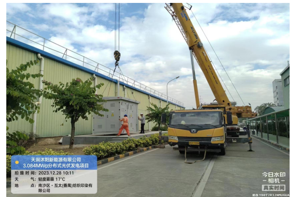
箱变吊装就位
