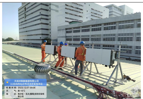
光伏逆变器安装
