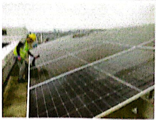
7#生活楼安装组件
