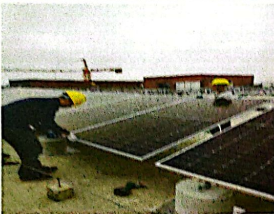
9#厂房安装组件
