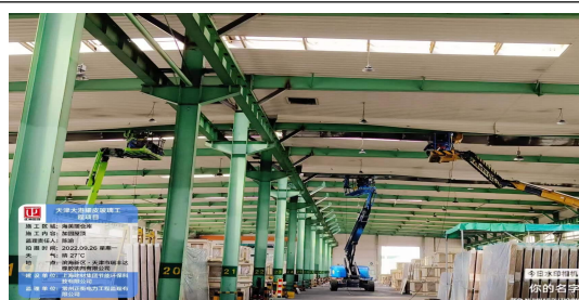
海美丽屋顶加固施工
