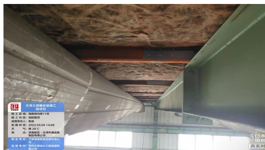
检查海美丽屋顶加固施工
