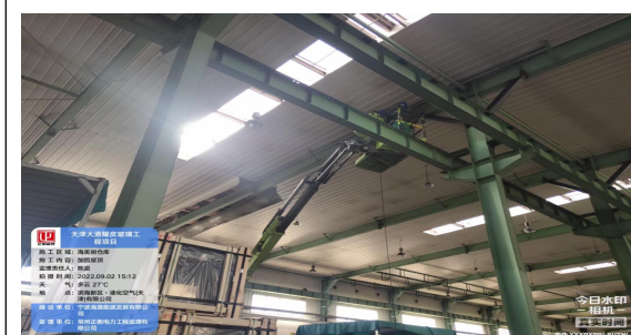
海美丽屋顶加固施工
