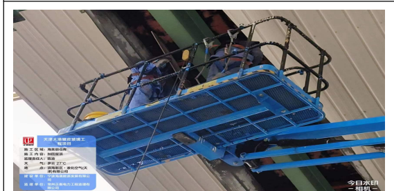
海美丽屋顶加固施工
