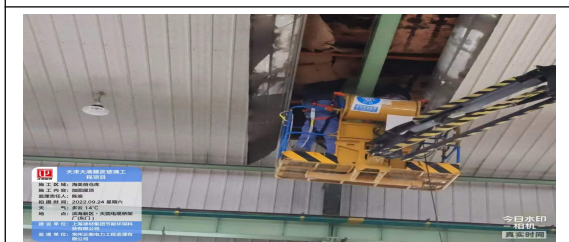
海美丽屋顶加固施工
