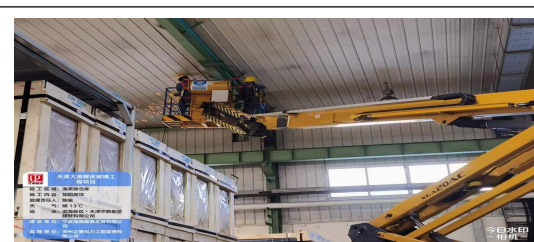
海美丽屋顶加固施工
