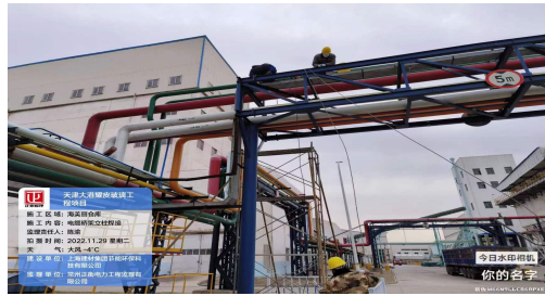
电缆桥架支架焊接
