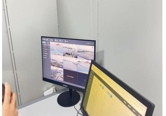
监控系统调试
