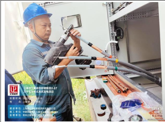
高压电缆终端制作
