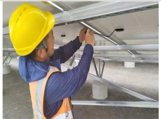
电缆敷设、M4 绑扎
