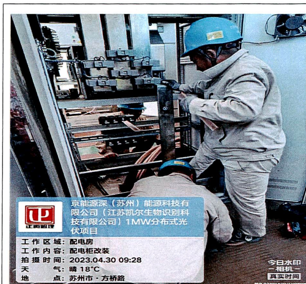
配电房原配电柜改造
