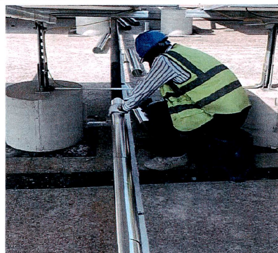
冲洗水管安装及保温施工
