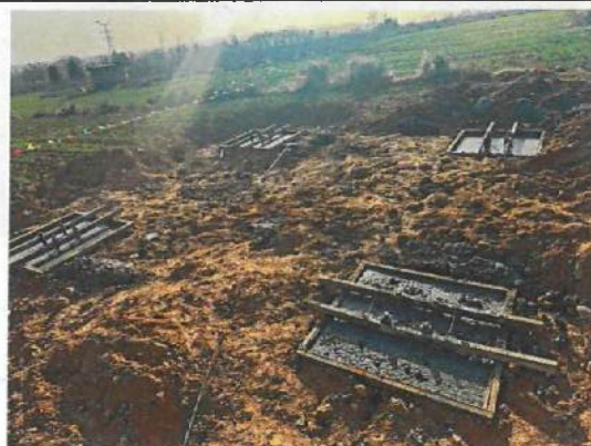
集电线路 AB4 浇筑完成
