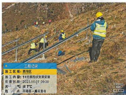
西沟区域 1#方阵光伏支架安装
