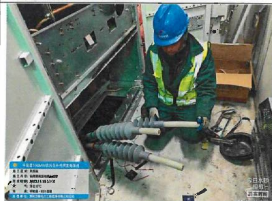
升压站站用变高压电缆头制作
