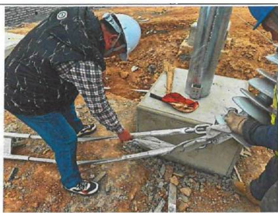
升压站耐张头制作质量检查
