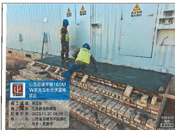
升压站生活舱台阶抹灰
