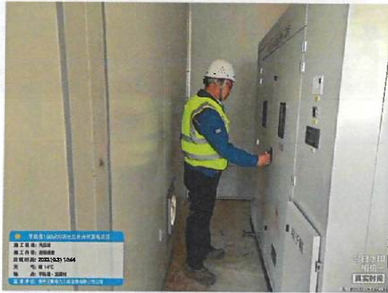
项目公司王轩升压站质量检查
