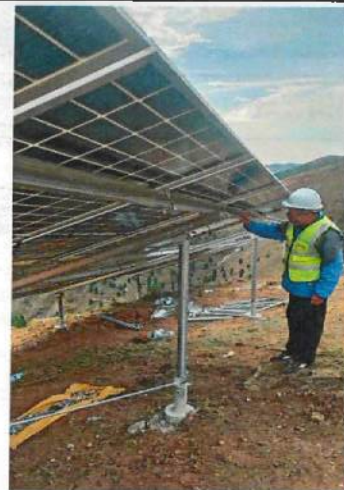
西沟区域组件安装质量检查
