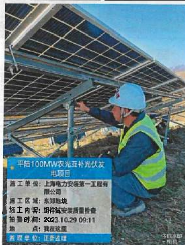
东郑区域组件试安装质量检查
