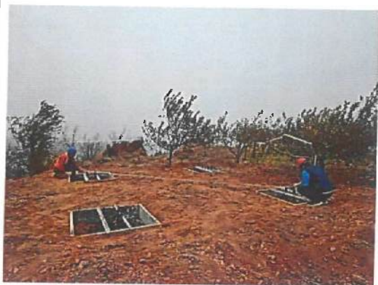
集电线路 BZ4 号铁塔基础钢筋模板验收
