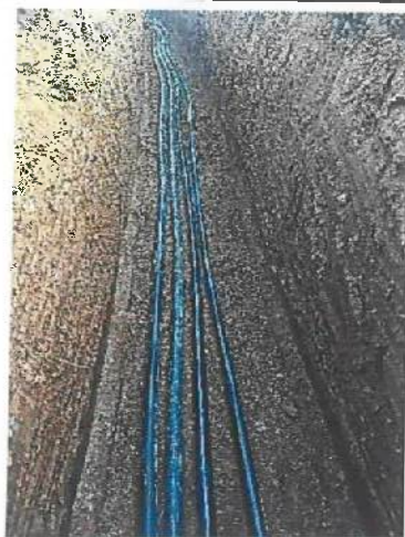
上苏地块交流电缆敷设
