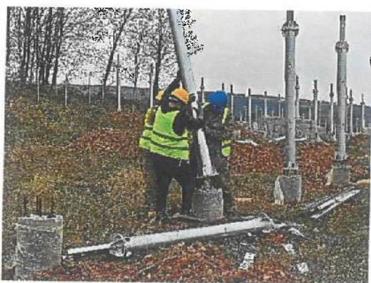
洪池地块立柱安装
