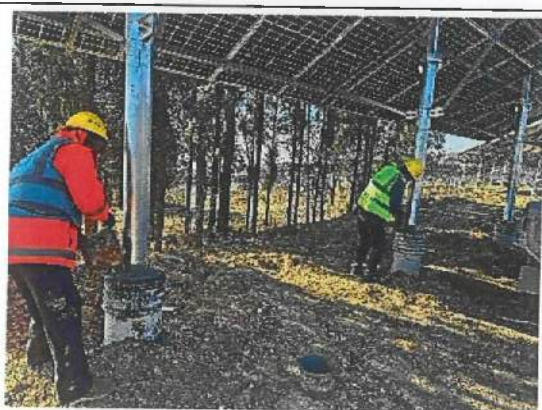
洪池地块桩基础二次浇筑
