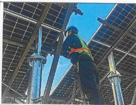
洪池地块接地小黄线安装
