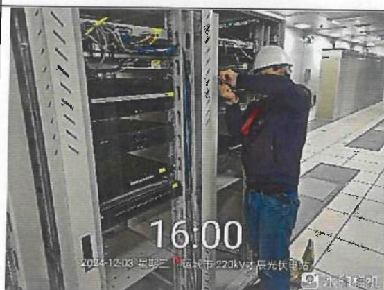
升压站智慧场站服务器安装
