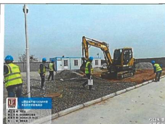
升压站 GIS 周围区域碎石铺设
