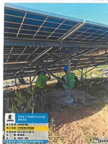
东郑区域组件接地黄绿线连接
