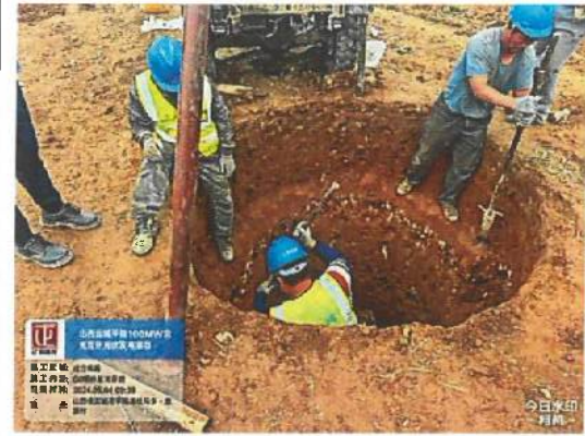
送出线路 G0 钢杆基坑开挖
