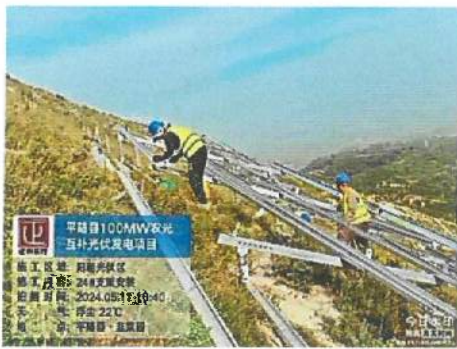
阳朝区域 24#地块支架安装
