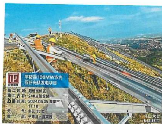
阳朝区域 24#地块支架安装
