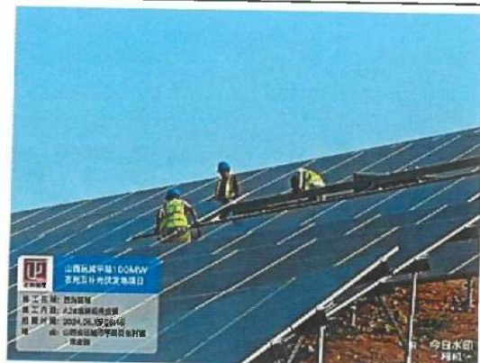
西沟区域 A2#地块组件安装
