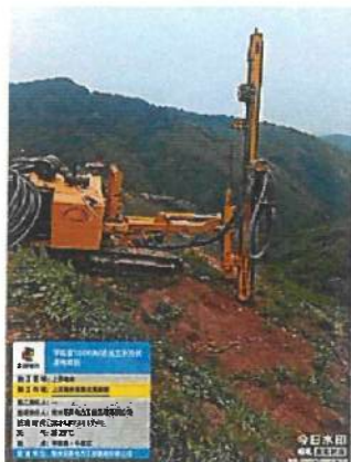
上苏区域桩基础引孔
