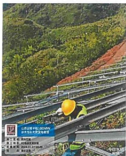
西沟区域 A3 支架安装
