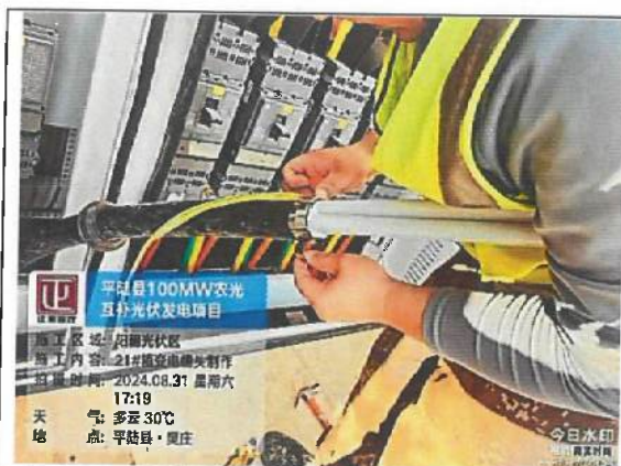
阳朝地块箱变电缆头制作
