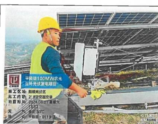
阳朝地块逆变器安装
