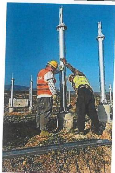
洪池 31 地块立柱安装
