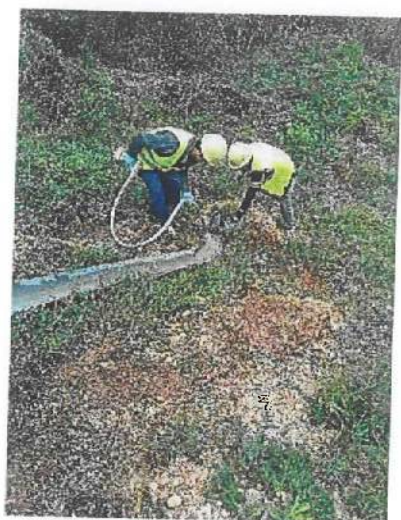
西沟地块 2 桩基础浇筑
