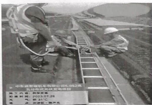
二联厂房桥架安装
