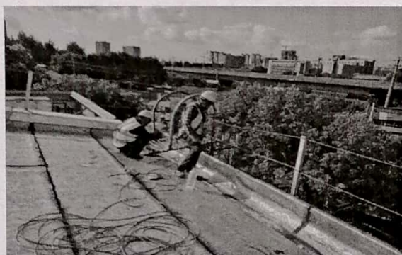
地梁防水材料粘贴
