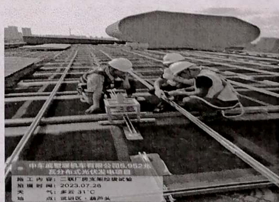
二联厂房支架拉拔试验
