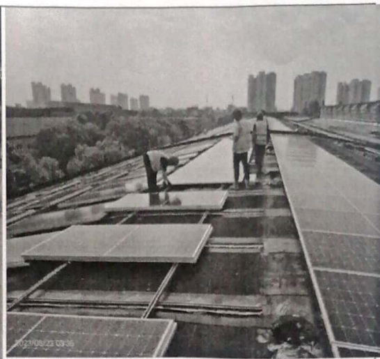
配件联合厂房组件安装
