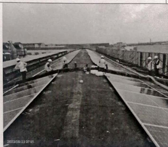
柴油机存放库组件安装
