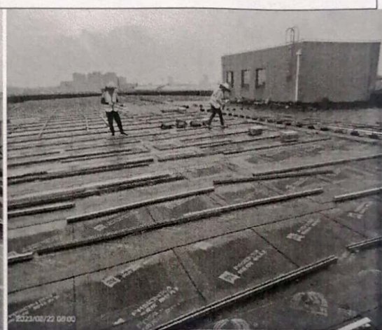
电器厂房地梁打胶
