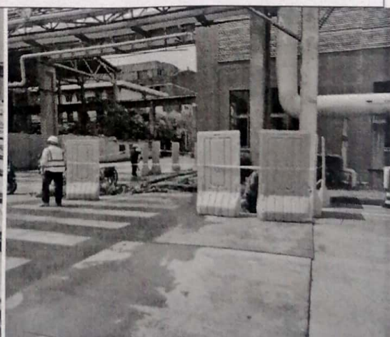
交流电缆路径施工
