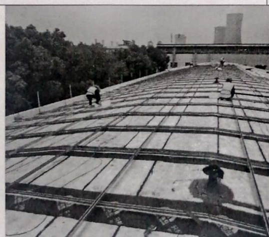
配件联合厂房支架安装
