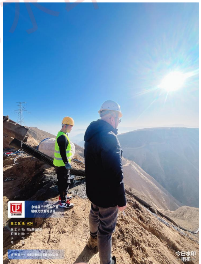
旁站 A24 基础浇筑
