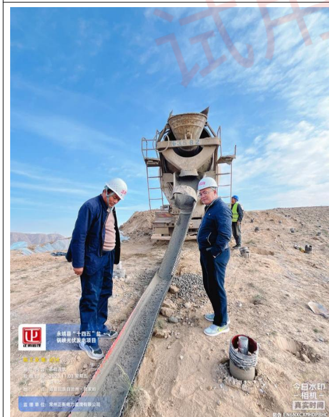
巡查 A14 基础浇筑
