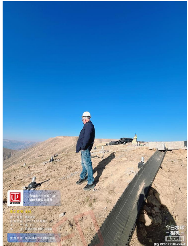
旁站 A14 基础浇筑
