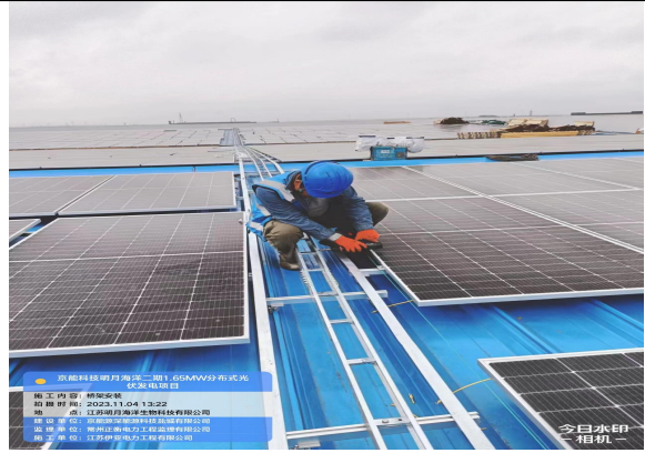
直流桥架安装
