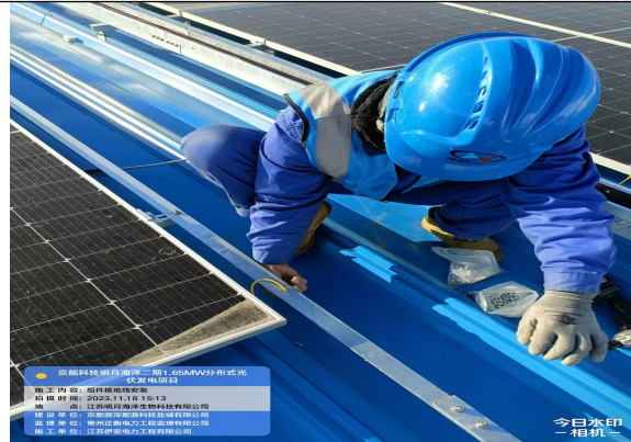
逆变器接地扁铁安装
