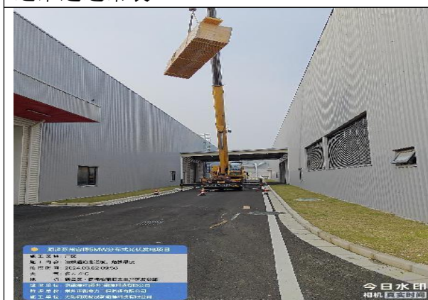
检查运维通道
