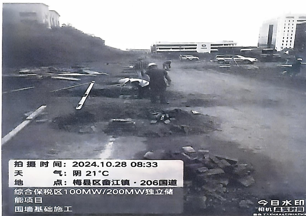
围墙基础施工
