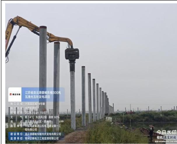
基础管桩打桩施工
