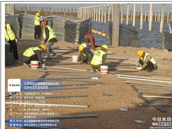
桁架三角撑组装
