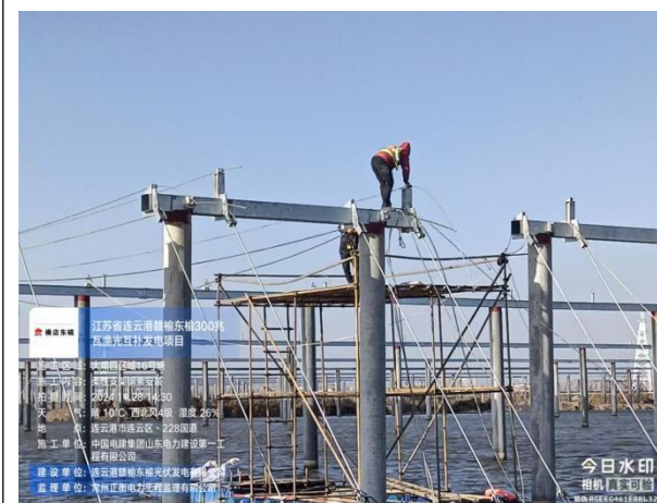
柔性支架钢索安装
