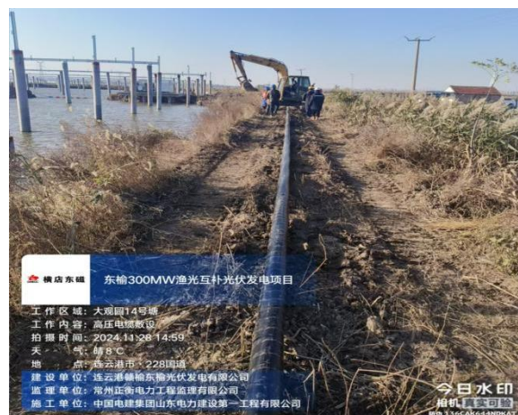
高压电缆放线
