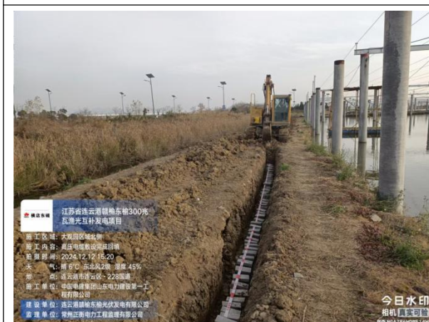
高压电缆沟回填
