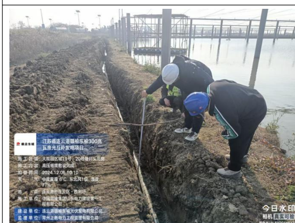
对高压电缆沟深度进行检查
