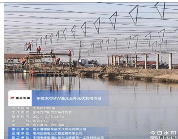
柔性支架三角撑安装
