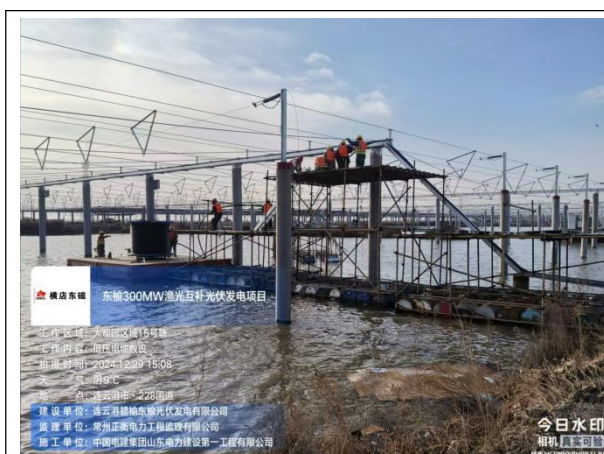
低压电缆敷设
