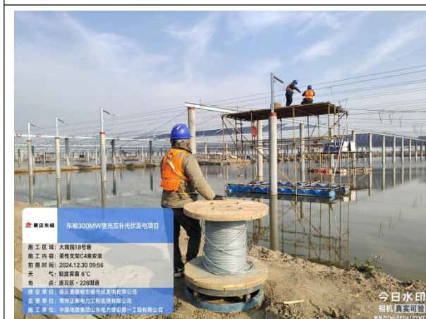
柔性支架 C4 索安装
