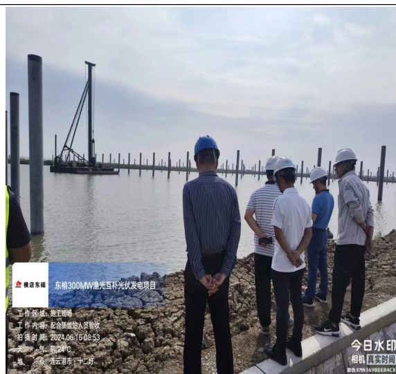
质监站来现场验收检查
