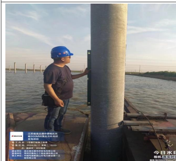
对现场施工质量进行检查
