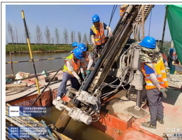
锚杆桩进场做试验桩
