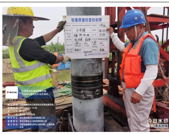
对现场管桩焊接及防腐施工进行验收
