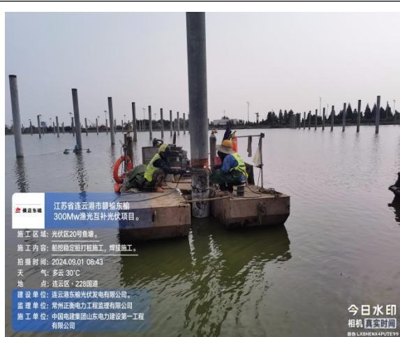
现场管桩焊接施工
