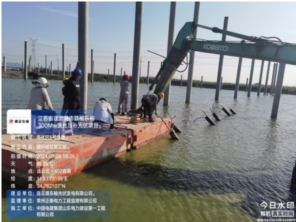
现场锚杆桩试验检测
