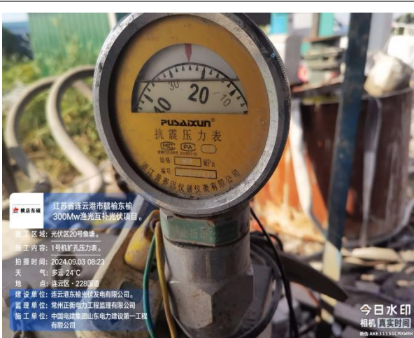
对锚杆桩压力值进行检查
