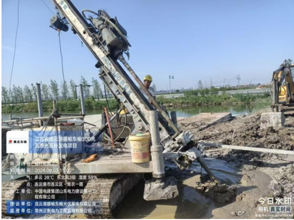
现场锚杆桩施工
