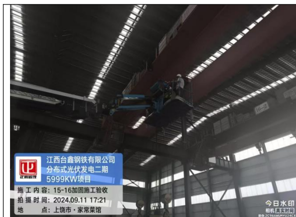
电缆进场材料检查
