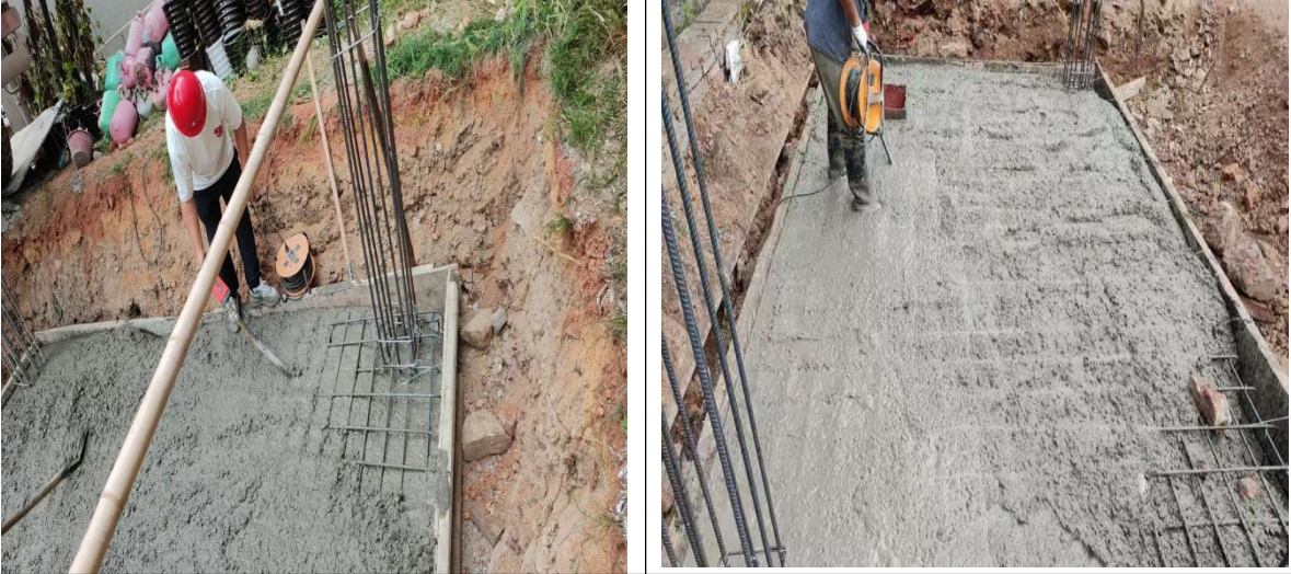
基础砌砖柱钢筋绑扎 柱钢筋检查
