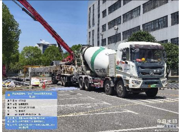
4号车棚短柱浇筑
