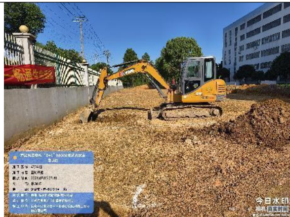
4号车棚基础开挖
