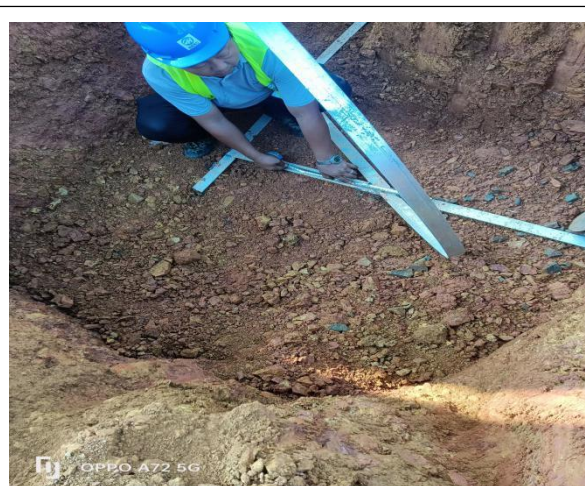
监理检查接地焊接长度
