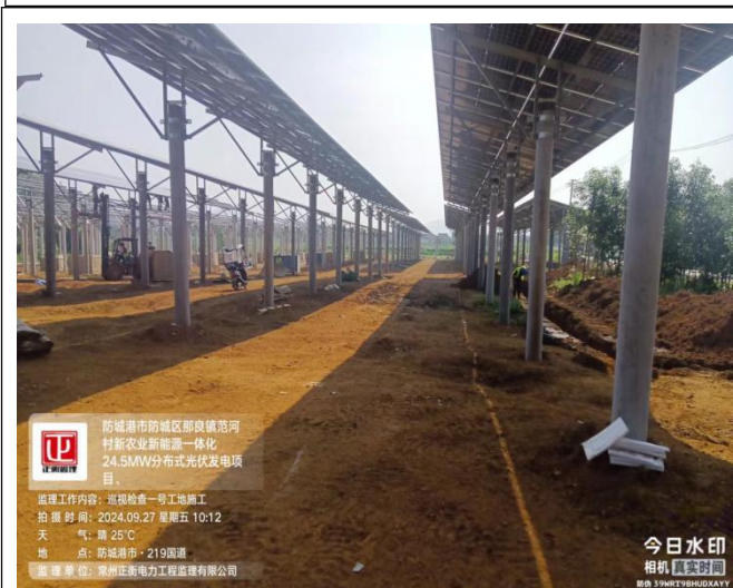
厂监理迎查组件安装
