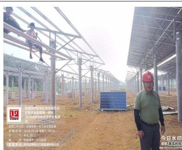
监理迎查支架安装
