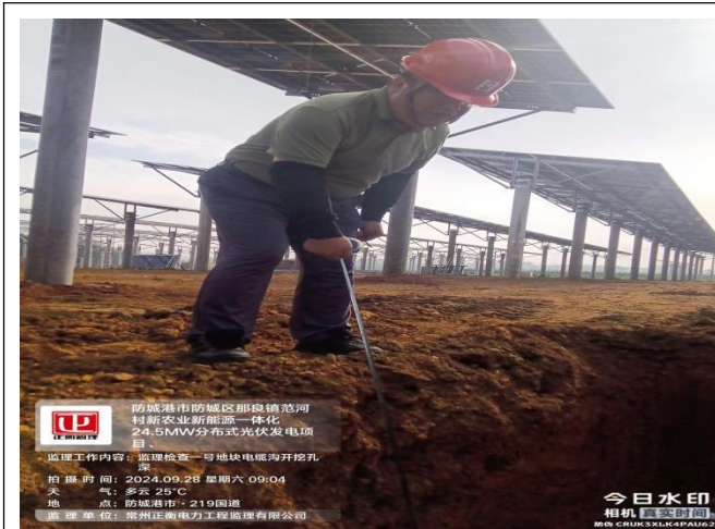
监理检查电缆沟深度
