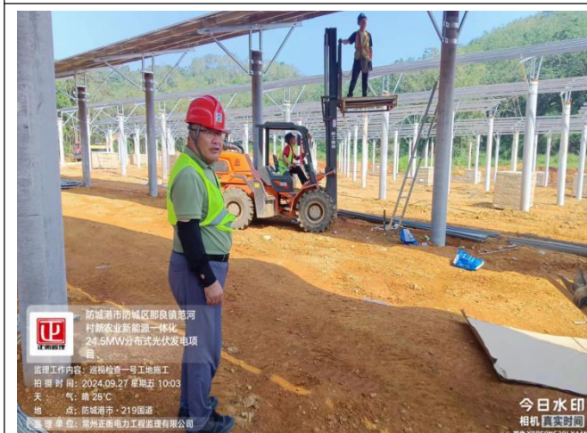
监理迎查支架安装
