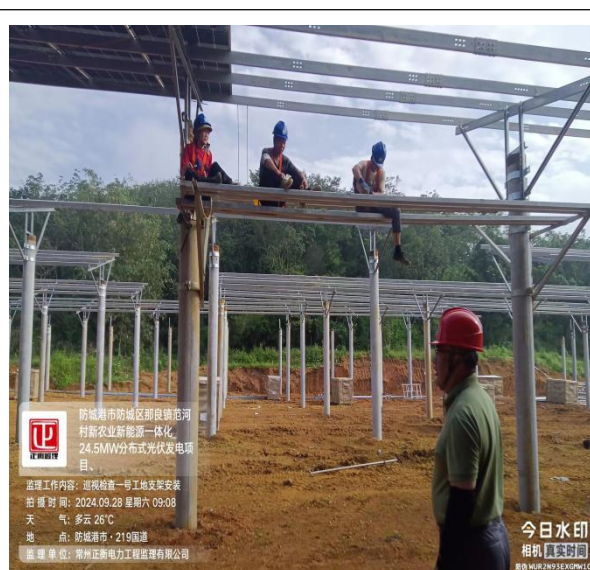
监理迎查支架安装
