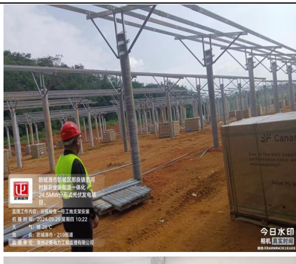
监理迎查支架安装
