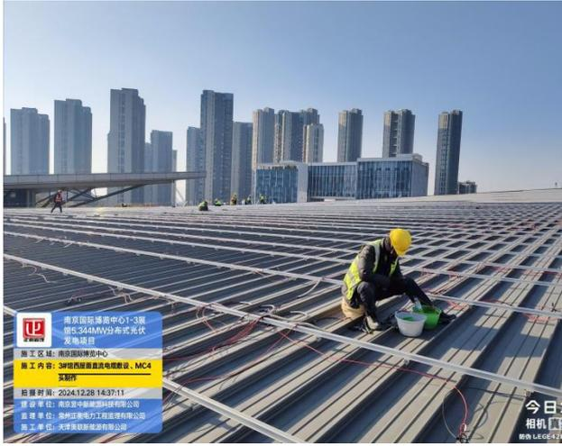
3#馆西屋面直流电缆敷设、MC4头制作
