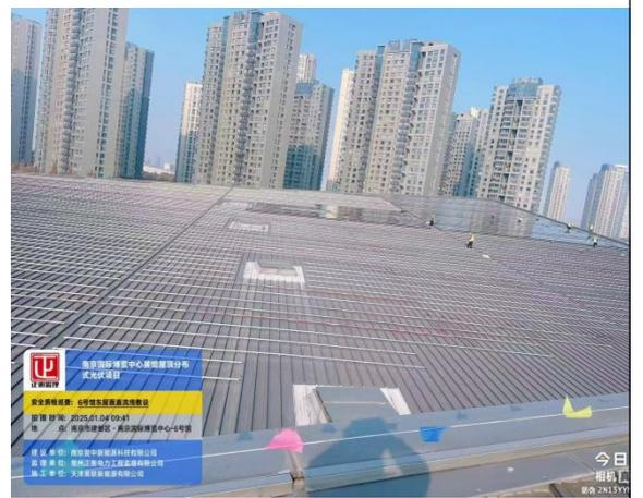
6#馆东屋面直流电缆敷设检查验收
