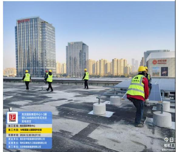
1#馆混凝土屋面组件铺设、安装
