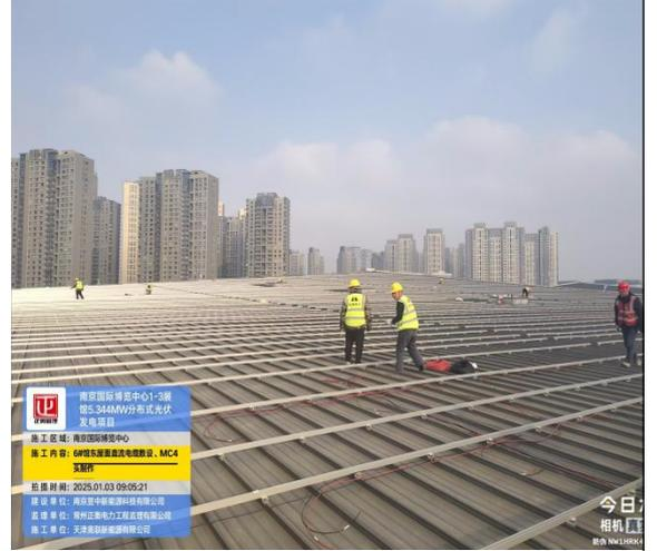
6#馆东屋面直流电缆敷设、MC4头制作
