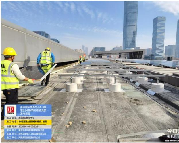
3#馆混凝土屋面组件铺设、安装
