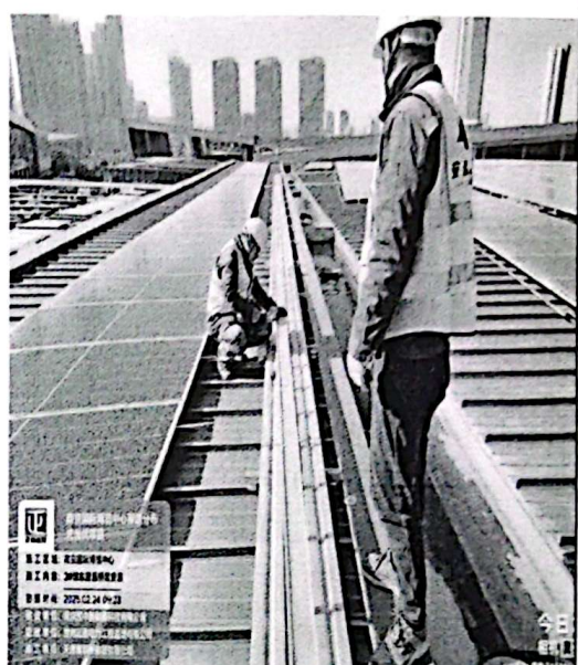
3#馆东屋面桥架安装
