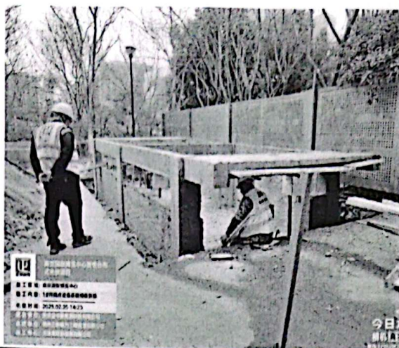
1#井网点设备基础模板拆除
