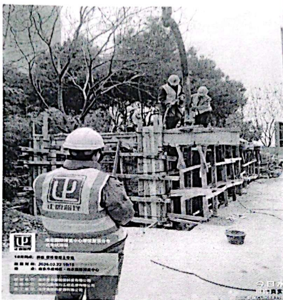
箱变顶板梁柱混凝土旁站
