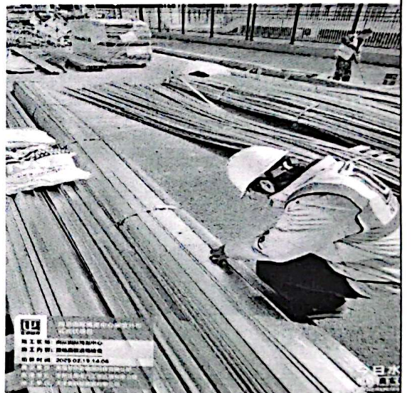
接地扁铁进场检查
