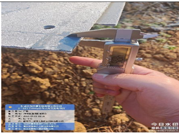
2#车间加固材料检查
