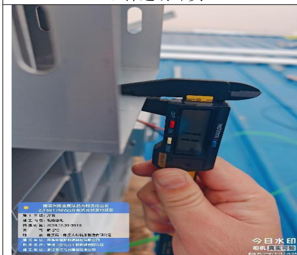
桥架材料检查
