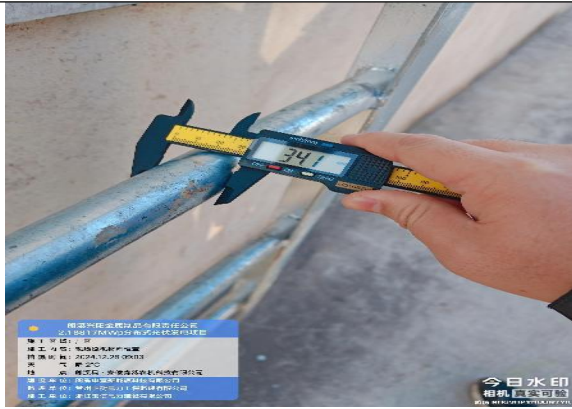
爬梯材料检查
