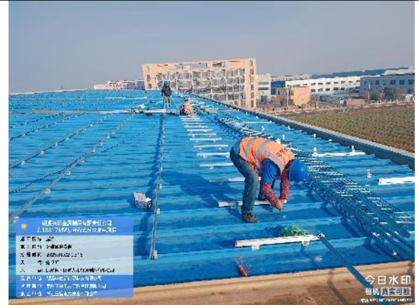
运维通道安装
