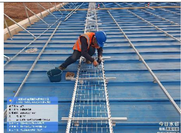
运维通道安装
