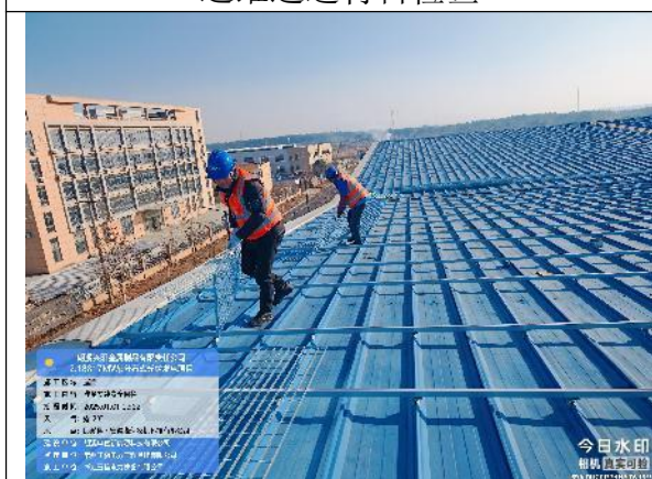
安全围栏安装
