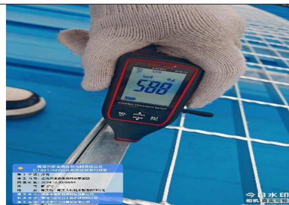
运维通道材料检查
