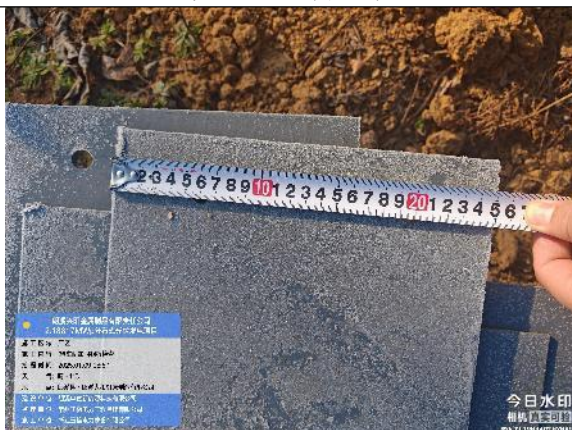
2#车间材料加固检查
