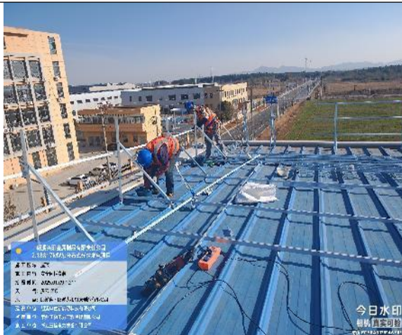
安全围栏安装
