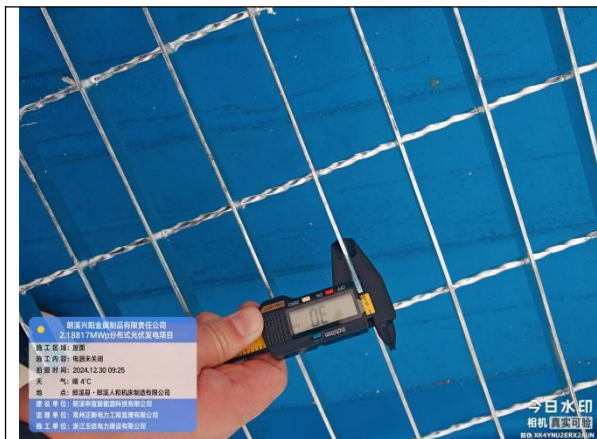
运维通道检查
