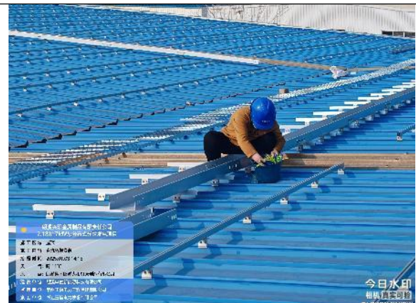
直流桥架安装
