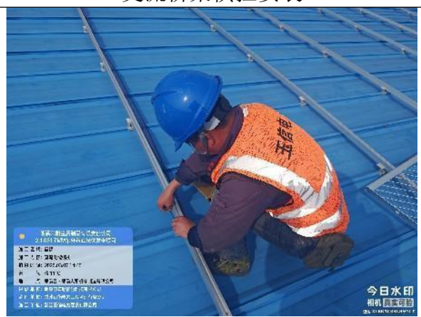
直流电缆绑扎
