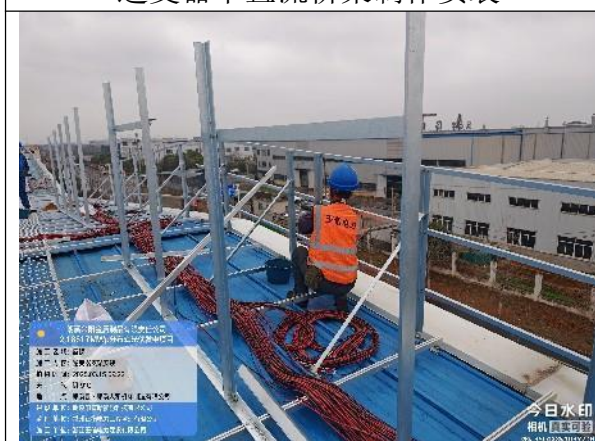
逆变器支架安装
