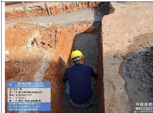
电缆沟电缆井并网柜垫层浇筑
