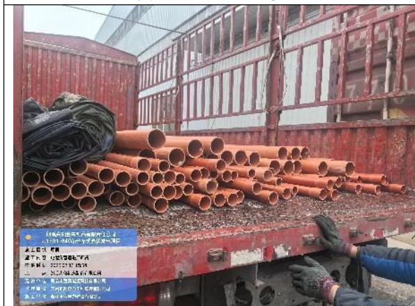
电缆沟预埋管进场卸货
