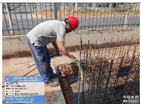
室外并网柜底板浇筑
