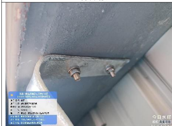
屋面接地点检查
