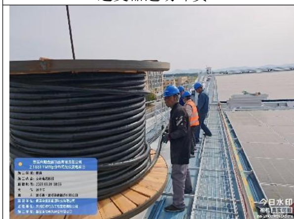
交流电缆敷设
