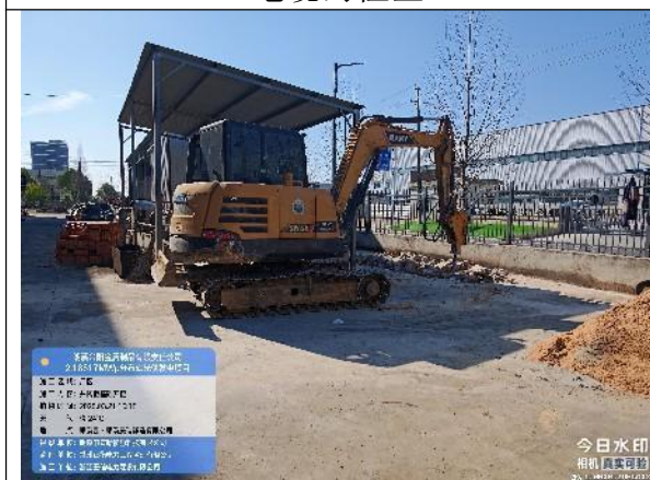
电缆沟电缆井并网柜基础开挖
