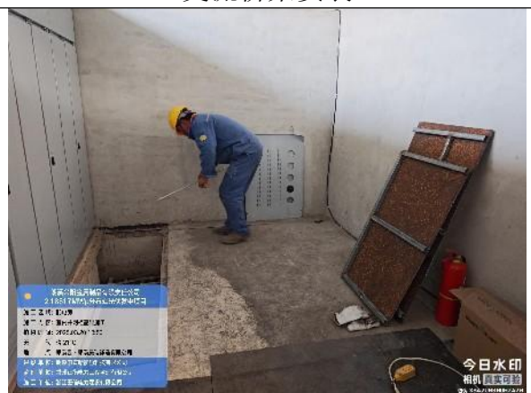
室内并网柜基础砌筑
