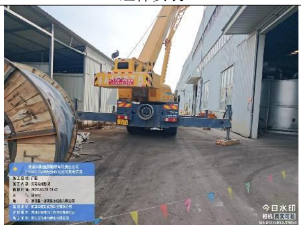
交流电缆敷设
