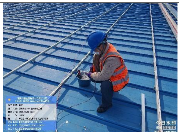
直流电缆MC4插头制作安装
