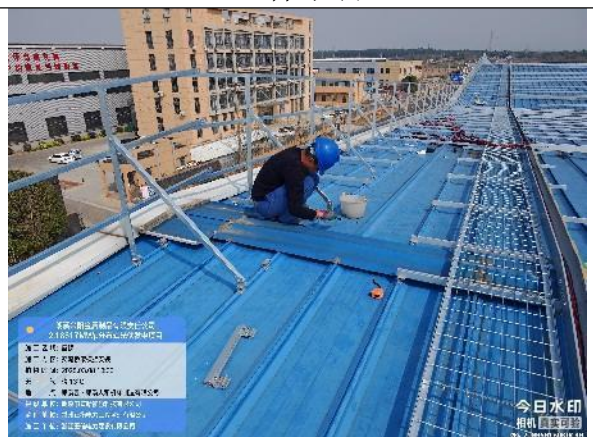
交流桥架横担安装
