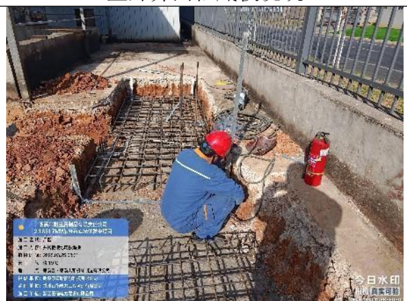
室外并网柜接地扁铁焊接
