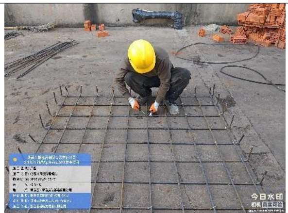
电缆井底板钢筋绑扎
