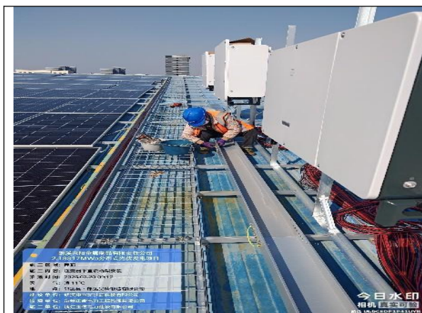
逆变器下直流桥架制作安装
