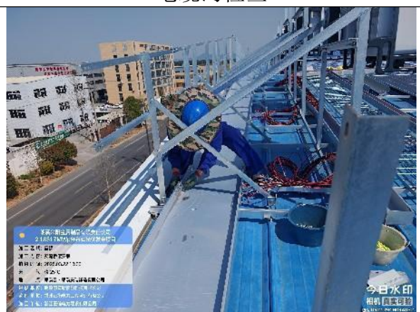
交流桥架安装
