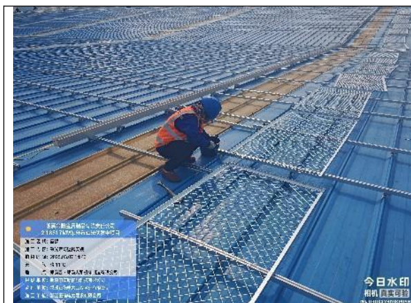
采光带防坠网安装
