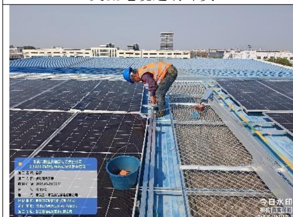
接地扁铁安装
