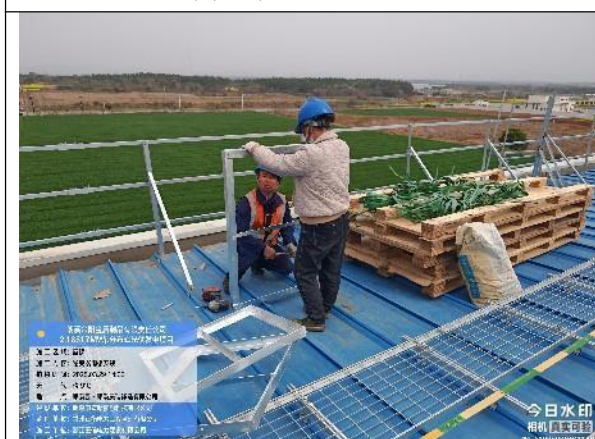
逆变器雨棚安装
