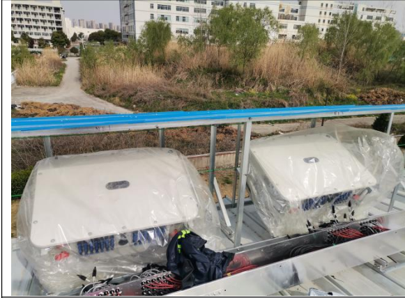
预制舱SVG基础检修通道安装
