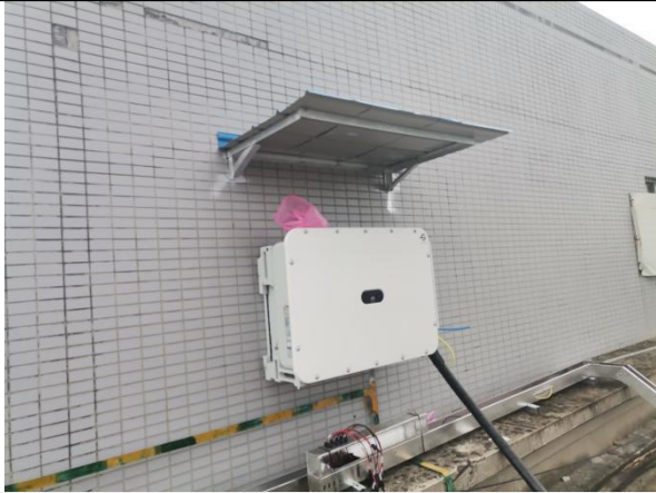
逆变器及遮阳棚安装
