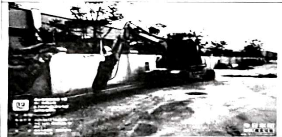
电缆沟破路
